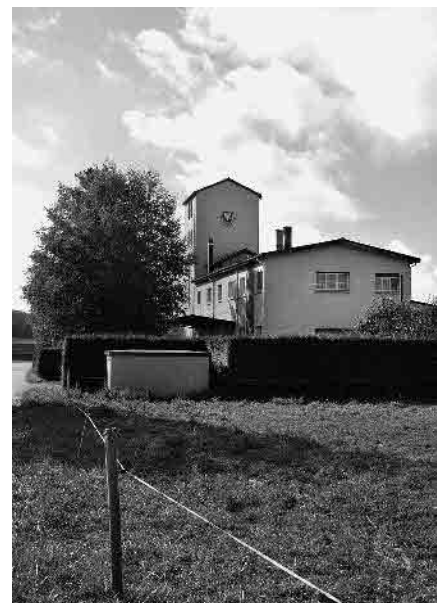
12 Anc. moulin industriel, 1958
