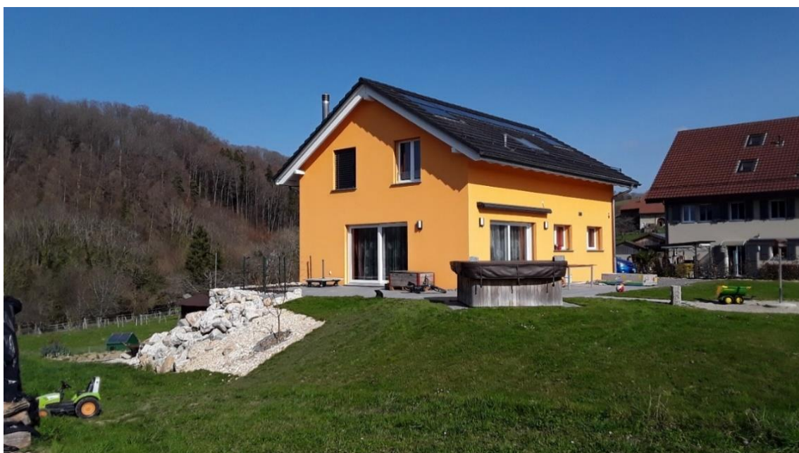
Figure 7 : Vue sur la parcelle 351 depuis la Route de Thierrens (Prise de vue 2). Construction récente.
