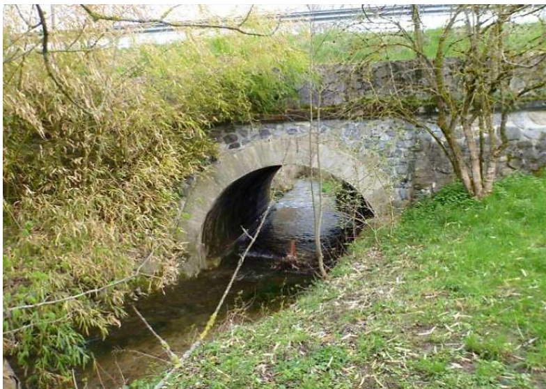
Figure 4 : Passage sous la route cantonale RC 414d
