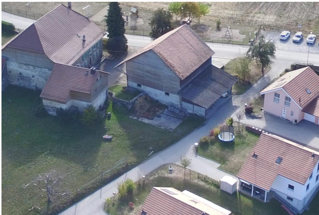
Extrait de la partie nord de la parcelle n°357 avec la surface bétonnée
